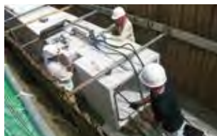
7. PC 鋼より線を4穴に通す
