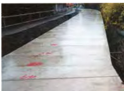
⑤ 据え付け完了
