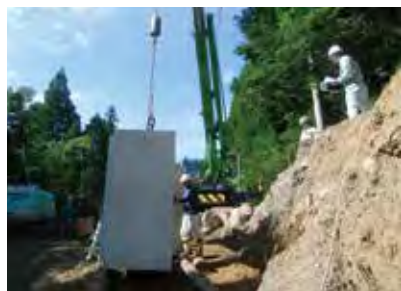
① クレーンによる荷降ろし
