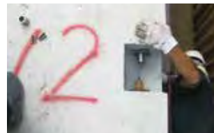
8. 最初のカップリング付ボックスにPC 鋼より線を定着
