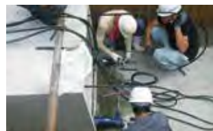
9. 最後のカップリング付ボックスに緊張用ジャッキをセット
