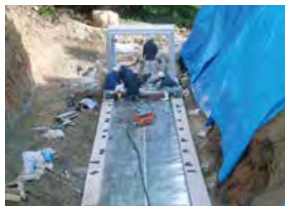
④ 据え付け位置での微調整
