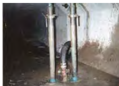
⑥ 底版モルタル充填工 (充填状況) 充填作業はコンクリートポンプ車を使用します。
