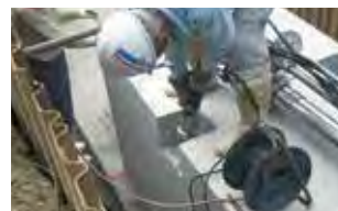
12. 最後のカップリング付ボックスの部分でPC 鋼より線を定着した後、切断
