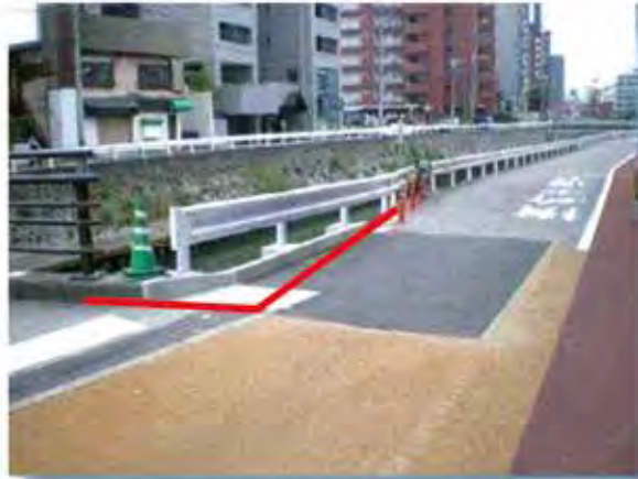
施主：福岡県北九州市小倉北区役所 工事名：境町1号線(上砂津橋)橋梁補修工事
