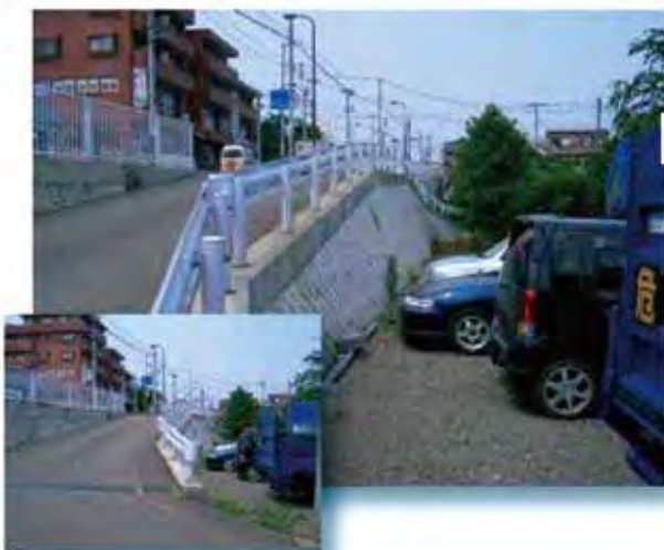
施主：東京都南多摩西部建設事務所 工事名：交差点改良工事
