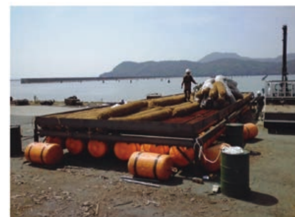
オイルフェンスに設置した状況
