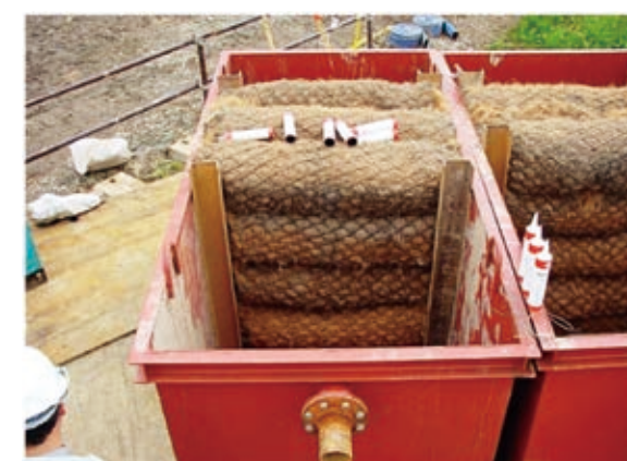
タンクに設置した状況
