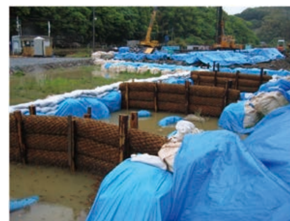
沈砂池に設置した状況
