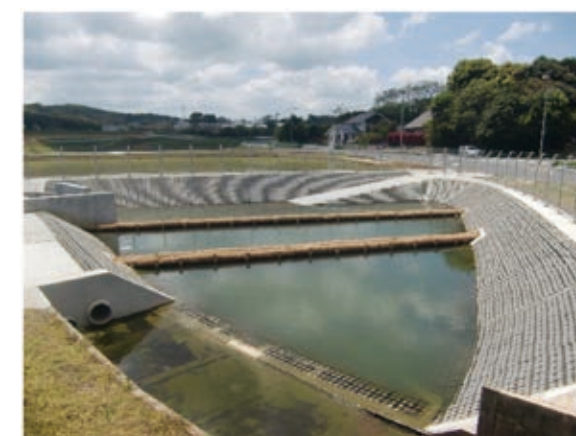
調整池に設置した状況
