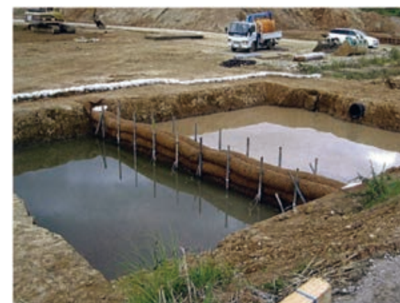
沈砂池に設置した状況
