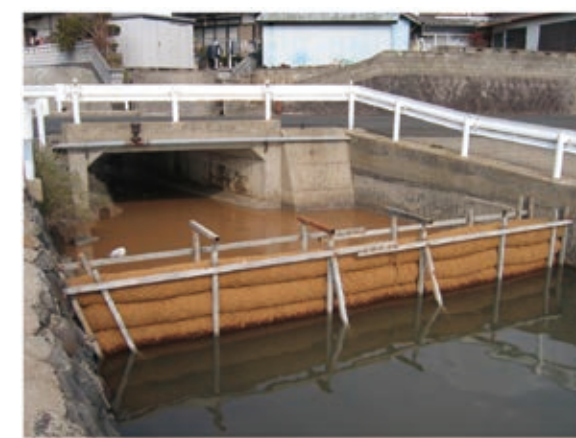
水路に設置した状況
