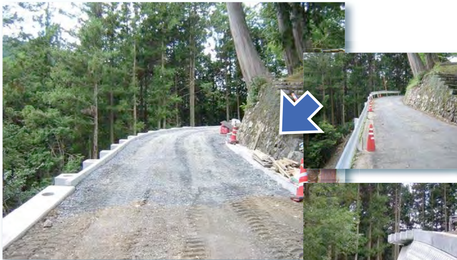
施主：愛媛県西予市役所城川総合支所 工事名：市道日浦線道路改良工事
