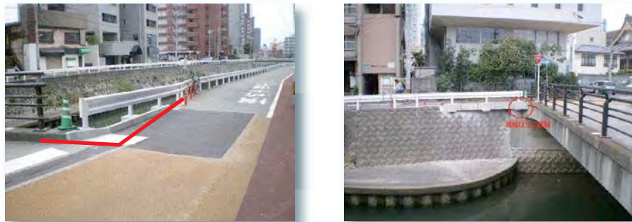
施主：福岡県北九州市小倉北区役所 工事名：境町1号線(上砂津橋)橋梁補修工事
