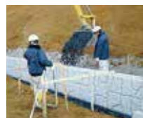
8 充填材の撒出し
