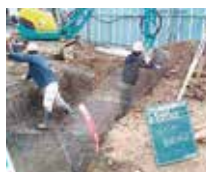
1 かごテンサー敷設
