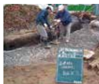
3 基礎碎石転圧
