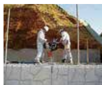
11 天端締め固め
