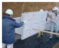
5 (最下段)本体据付け
