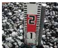
10 連結材の設置
