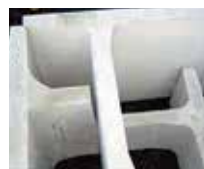
12 隅角部設置、端部止め施工状況
