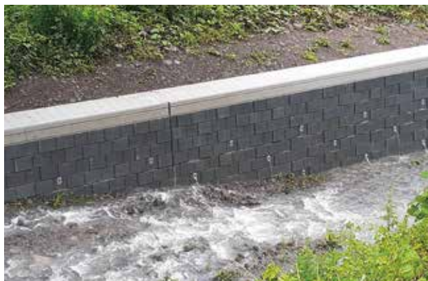
平石川 河川災害復旧 (長崎県)
