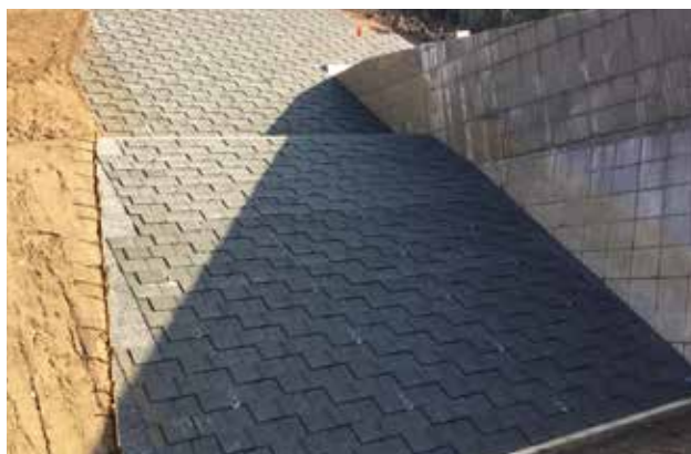
緩勾配施工写真
