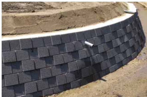
カーブ施工写真
