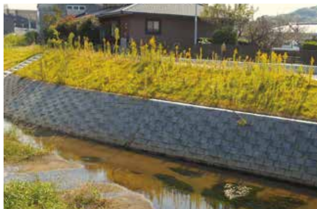
山犬原川 勾配変化 R 施工 (佐賀県)
