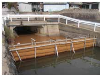
水路に設置した状況
