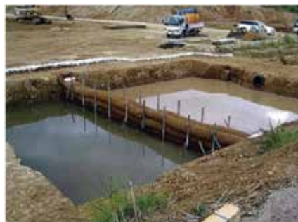
沈砂池に設置した状況
