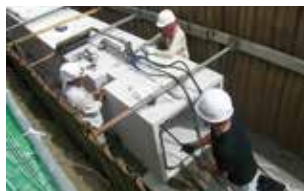
7. PC 鋼より線を4穴に通す
