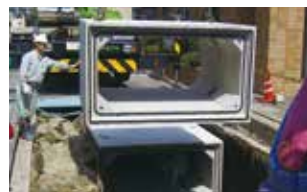
4. カップリング付ボックスを据え付け
