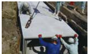
6. カップリング付ボックスを終端に据付
