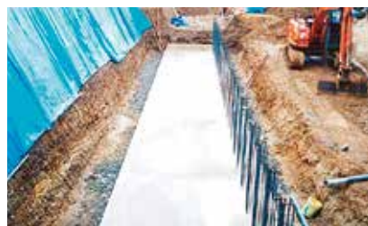
3 現場打ち底版打設、脱型
