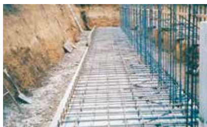
2 フーチング部筋組立
