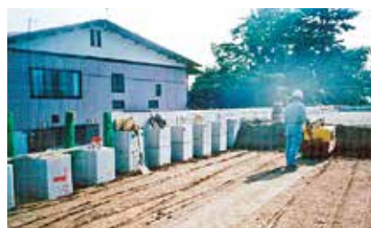
6 背面土埋め戻し
