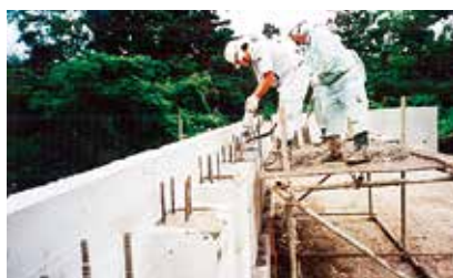
5 胴込コンクリート打設
