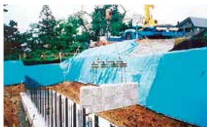
4 PCa 部材据付
