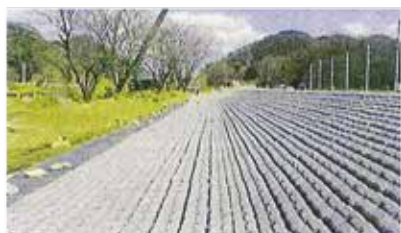
⑦ 施工完了
