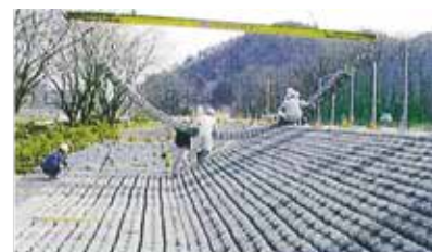
③ 専用吊り金具にてマット布設
