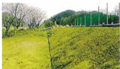
① 法面整形
