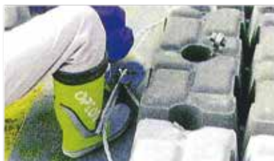
⑤ 上下端連結処理 (ワイヤークリップにて)
