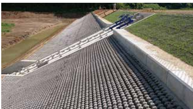
池ノ平地区ため池 平成30年度ため池等整備事業(危険ため池) 池ノ平地区工事
