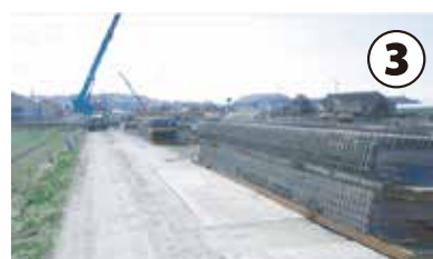
仮置 施工しやすいように分散して仮置します。
