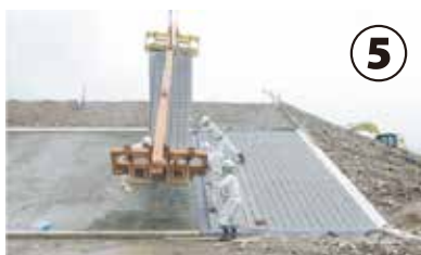
連結 ソルコマットのフィルタークロス余端部のソルコマットを順次重ね合わせていきます。
