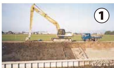
整地 施工面はできるだけ平らに整地します。
