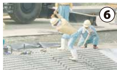
アンカーピン打設 安定方法としてアンカーピンを打設します。
