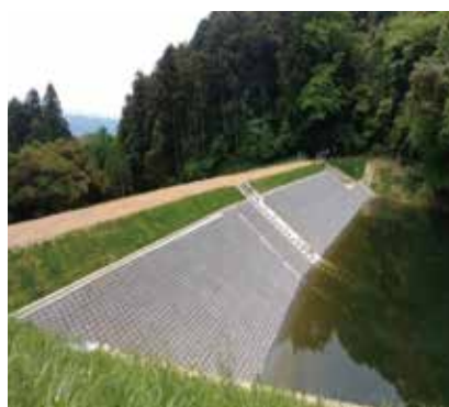
福岡県：寺前地区ため池 (防災 80)
