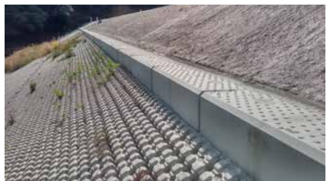
目引地区ため池 令和2年度ため池等整備事業(危険ため池) 目引地区工事
