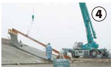
施工 重機によってマットを吊上げ、所定の施工面に設置します。
