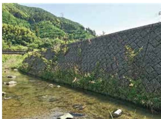
スマート間知ポーラス / 福岡県 (八木山川)
